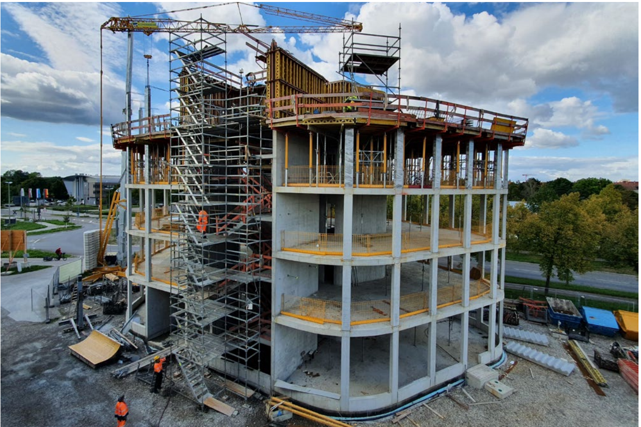
Baubeginn war im Frühjahr, im Frühsommer waren bereits vier von fünf Etagen betoniert
